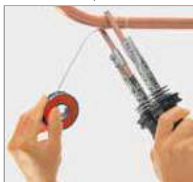
Nahřívání pájeného spoje bez otevřeného plamene
